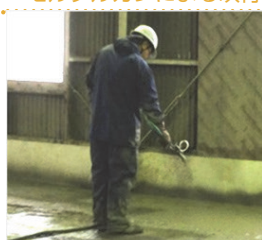
モルタルガンによる吹付け
