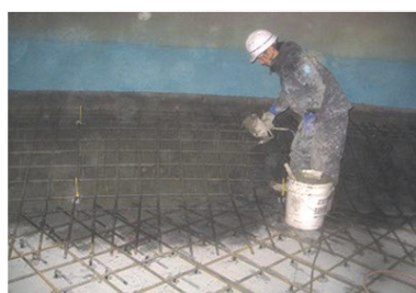
リシンガンによる吹付け 鉄筋を障害とせず施工
